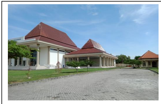
Jalan dan Parkir sisi samping
